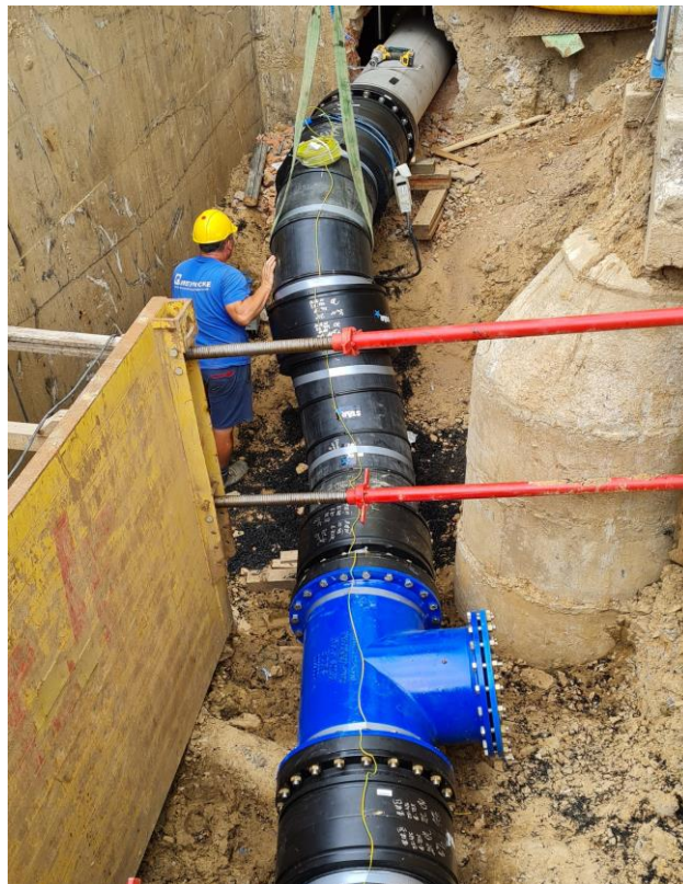
Foto: Propojení nového potrubí na VDJ Slatiňany
