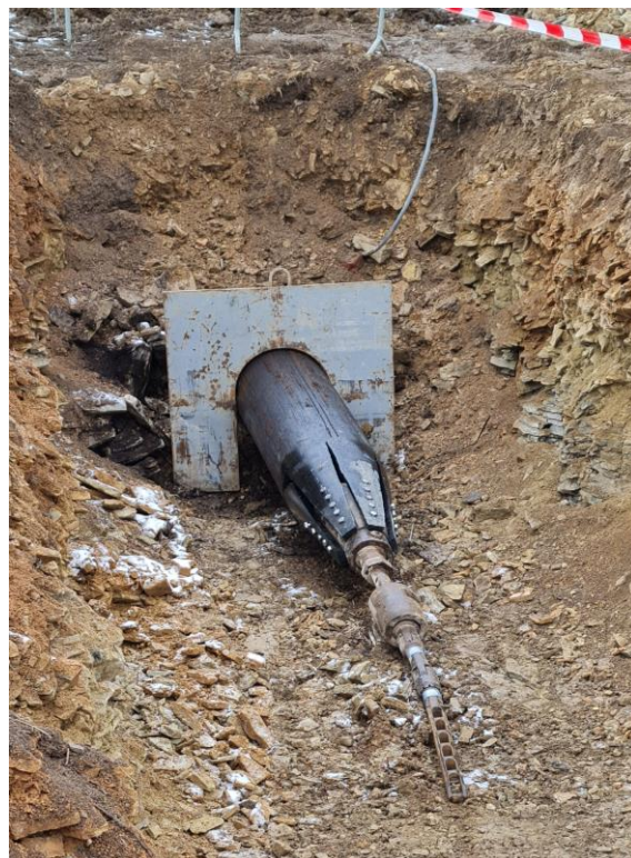
Foto: Čelo potrubí po zatažení a uvolnění sil
