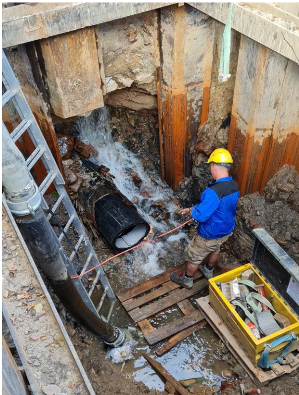
Foto: Práce po zatažení pod řekou Chrudimkou
