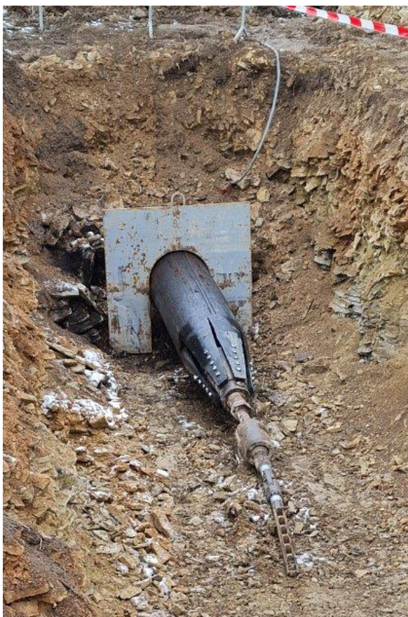
Čelo potrubí po zatažení a uvolnění tažných sil.
