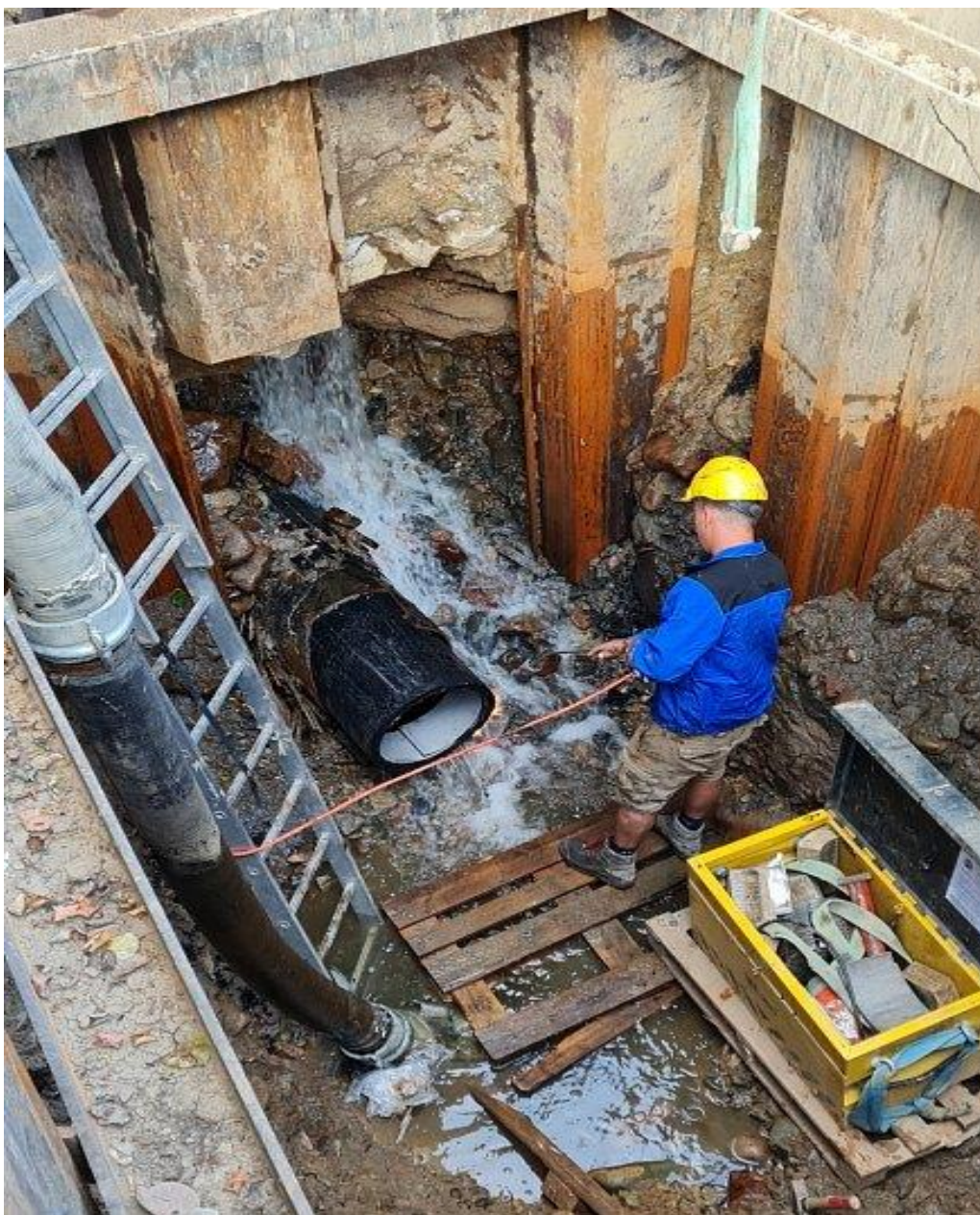
Rekonstrukce vodovodu pod Chrudimkou.
