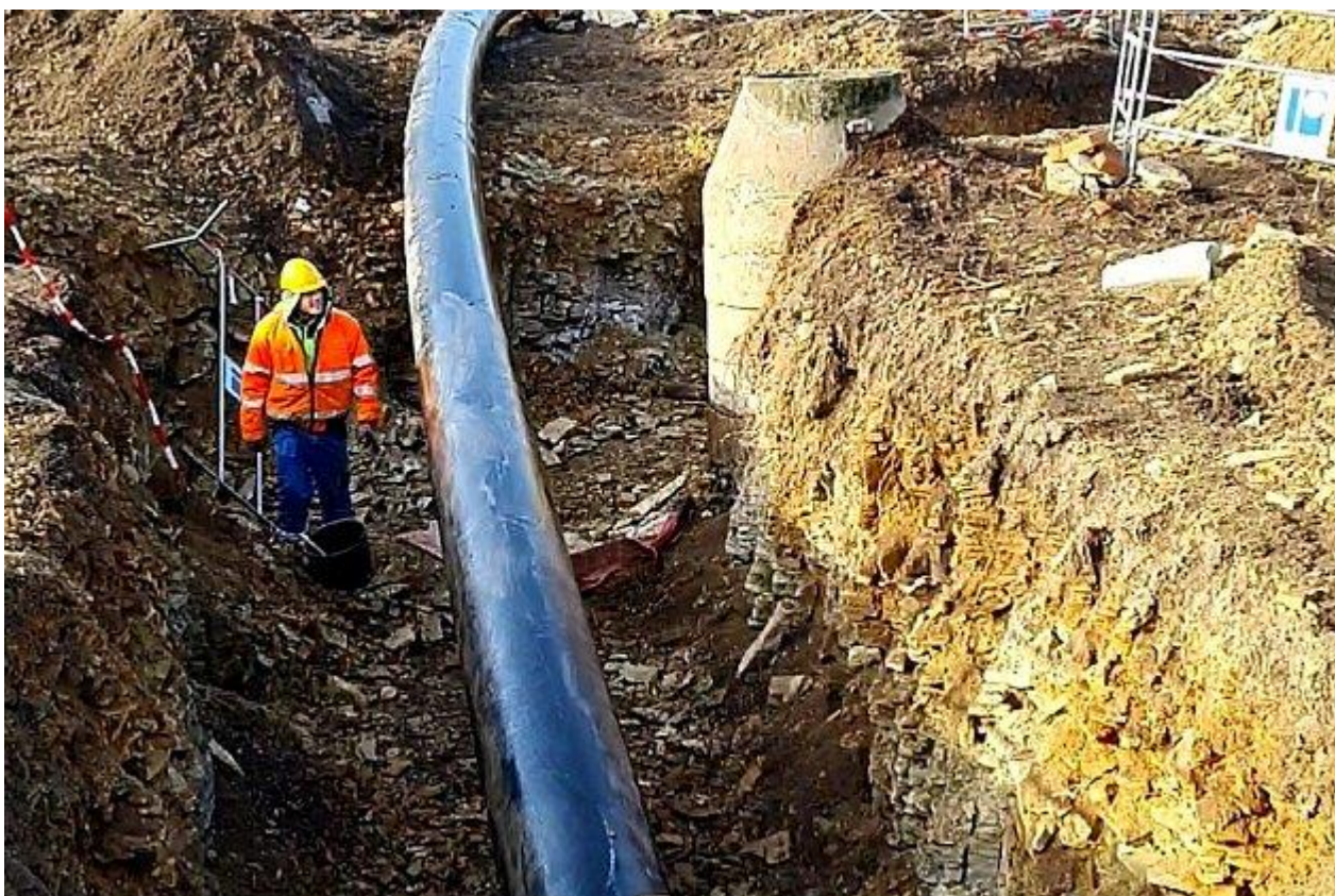
Práce na potrubí po jeho zatažení pod řekou Chrudimkou.
