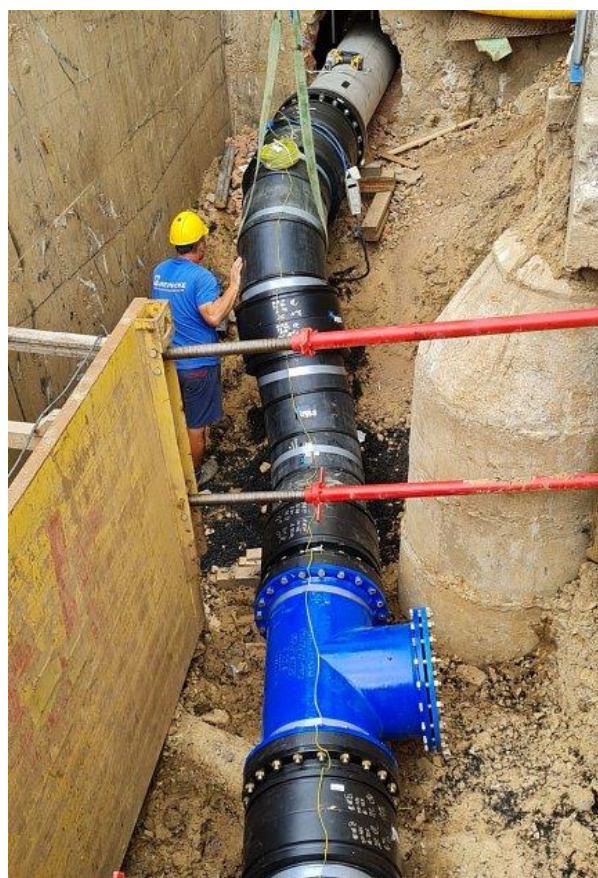
Propojení nového potrubí do VDJ Slatiňany.
